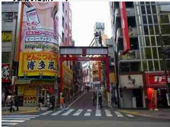
完成した新アーチ
